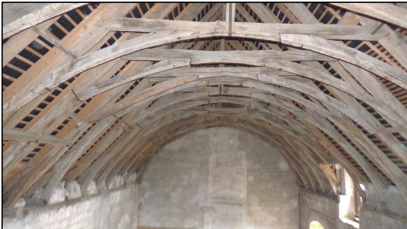
Figure 183. Superbe charpente : les travaux d'entretien (XX<sup>e</sup> siècle) sont parfaitement identifiables ; on a, entre autres, ajouté des chevrons de sapin entre les fermes de chêne.
