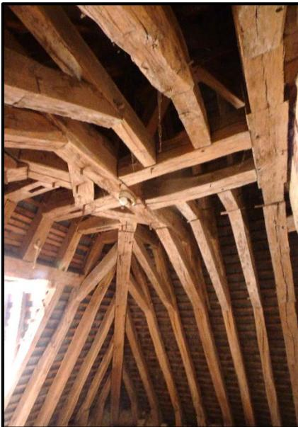
Figure 152. La charpente en carène de navire inversée.
