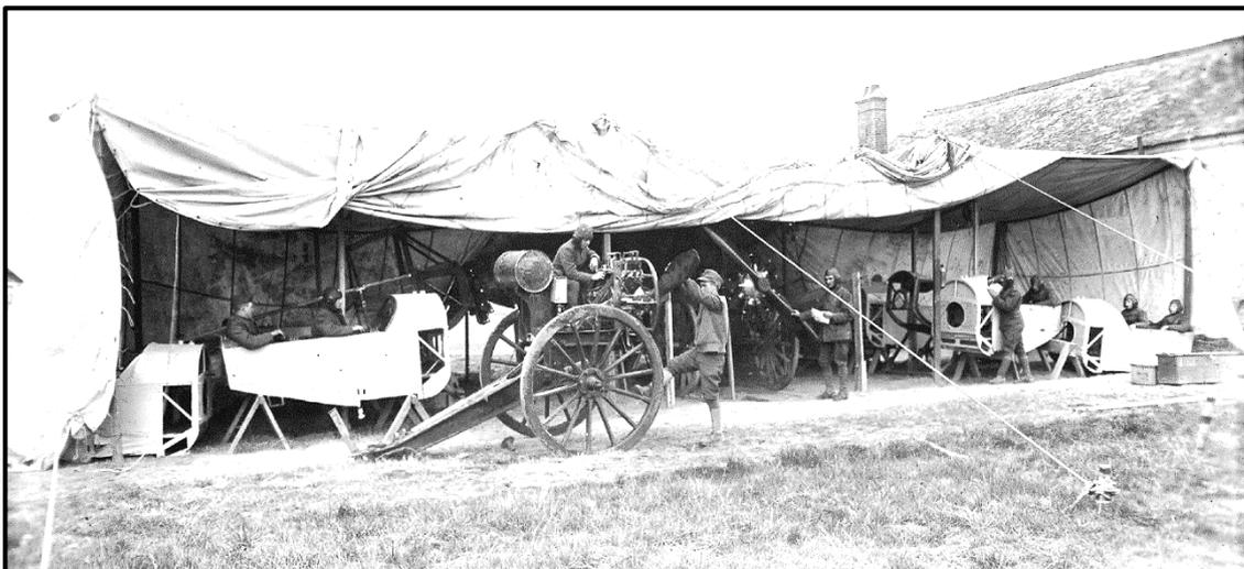
Figure 308. Bancs d'entraînement à la communication par micro entre l'observateur et le pilote. A proximité on a disposé un moteur d'avion que l'on va faire tourner pour reproduire l'environnement sonore. (Photo Archives US)
