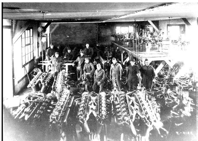
Figure 300. La salle des moteurs ; remarquer les moteurs 12 cylindre en v au premier plan et les moteurs rotatifs au fond à droite (Photo Archives US)
