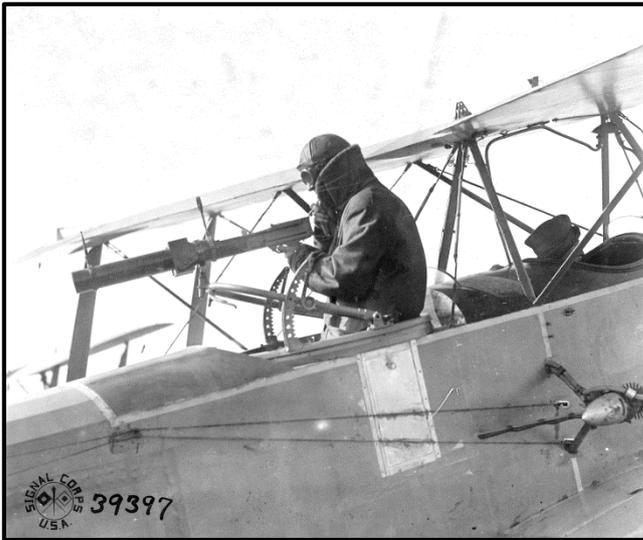
Figure 314. Pour simuler les combats aériens et valider les conditions de tir, la mitrailleuse a été modifiée en appareil photo. Sur la figure ci-dessus, on identifie la présence du boîtier photo par la partie parallélépipédique en milieu du canon. Lorsqu'on appuie sur la gâchette un cliché est pris. (Photo Archives US)
