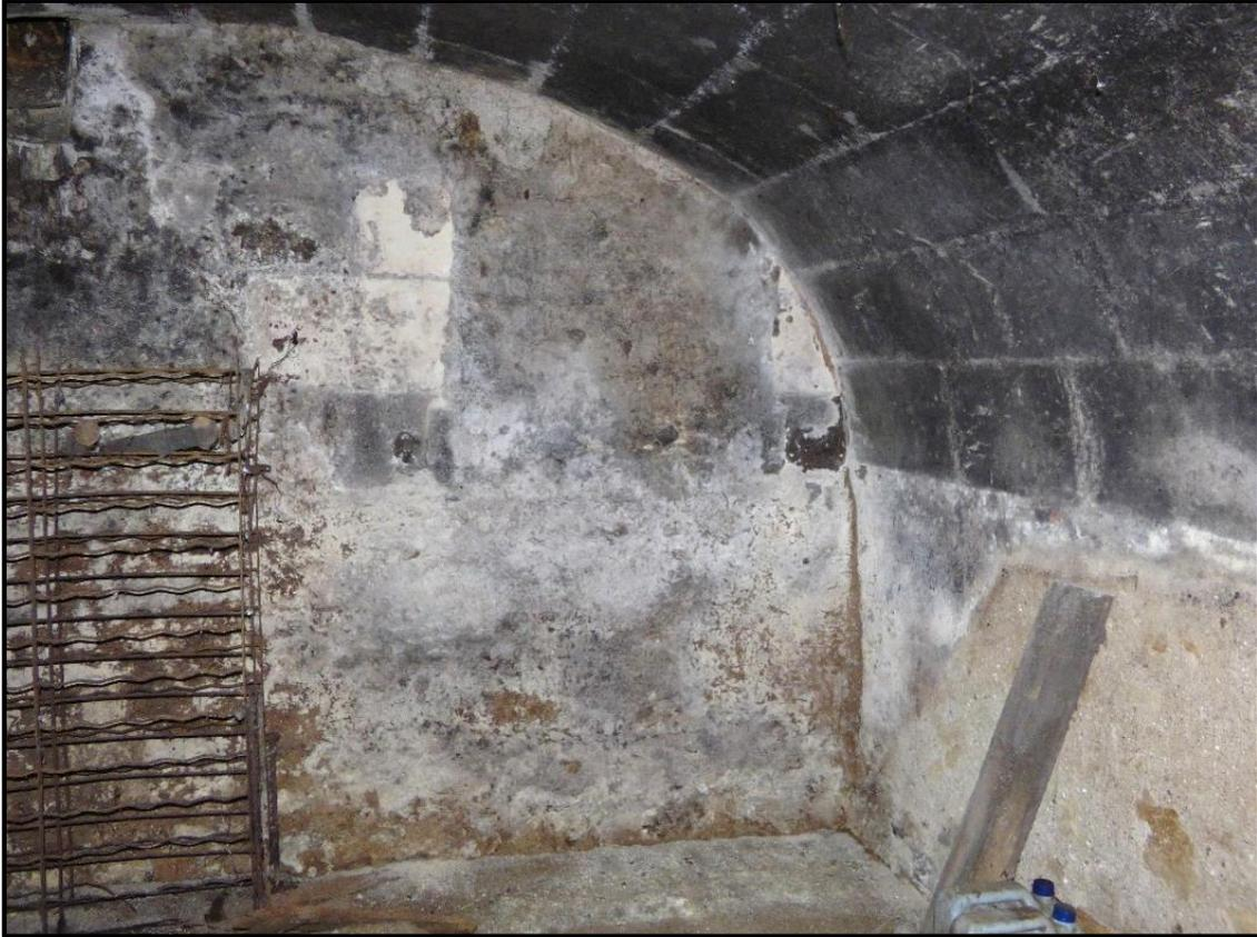
Figure 186. Cave récemment installée (XIX<sup>e</sup> ou XX<sup>e</sup>) s'appuyant sur le mur de refend, et occupant une partie inférieure de la construction du XII<sup>e</sup>.
